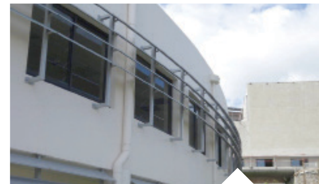
High School Nord, LA RÉUNION (97) Architect: Alain Bocquée | Installation: Atelier du Port
