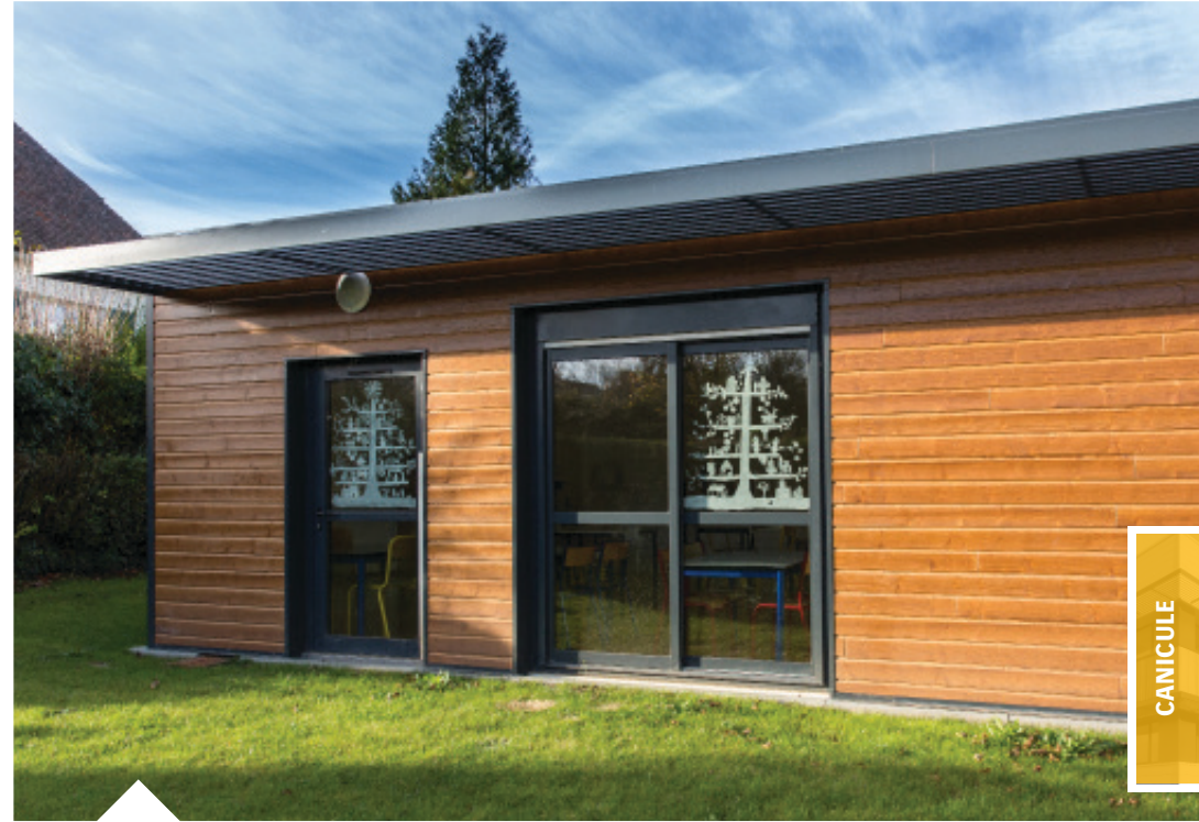
Kindergarden and recreation center, FONTAINE-ÉTOUPEFOUR (14) Construction & Installation: Module Création
