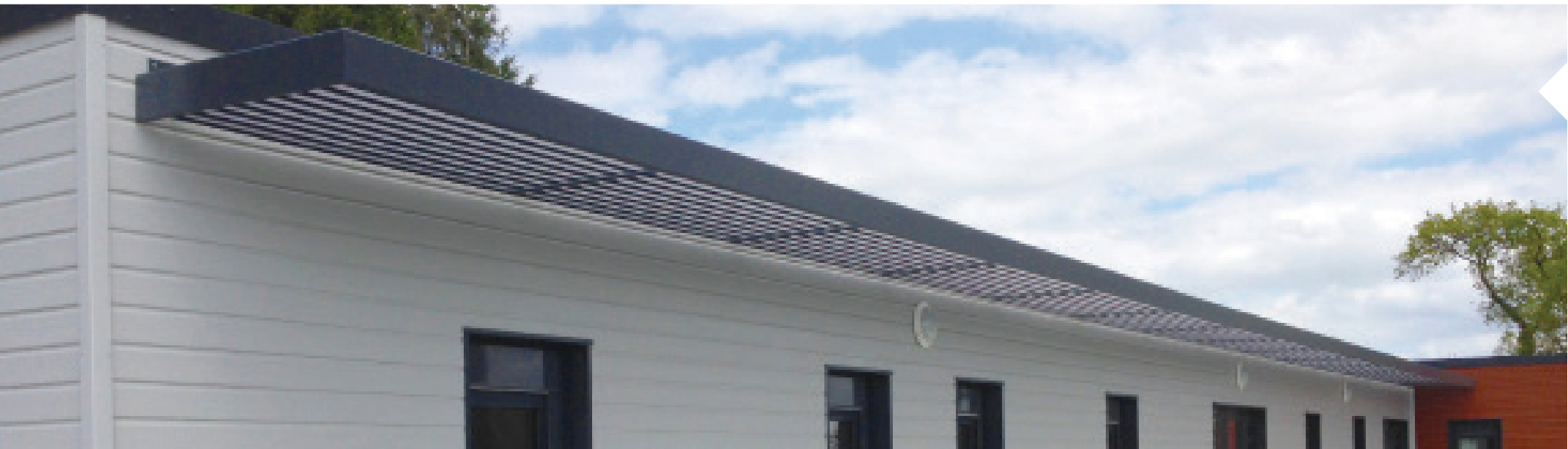
Visitor Center, CORSEUL (22) Construction & Installation: Module Création
