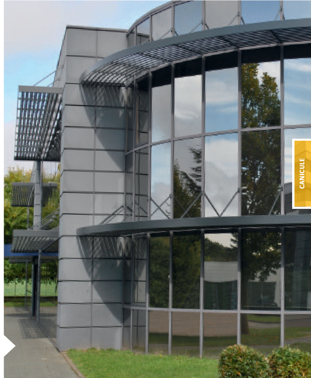
Faurecia, BRIÈRES-LES-SCELLÉS (91) Installation: Le Port Christian
