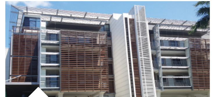
Hôtel de Région, SAINT-DENIS, LA RÉUNION (97) Architect: Cabinet Grouard | Installation: Atelier Du Port
