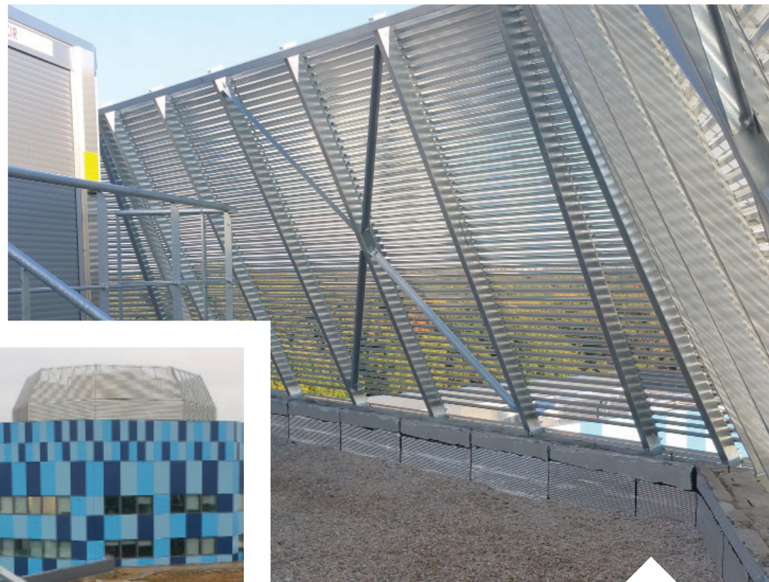
Crédit Agricole, GUYANCOURT (78) Installation: Poulingue
