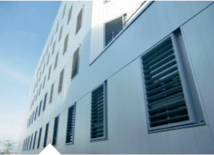
Tours Météor 3, SAINT-NAZAIRE (44) Architect: Jean-Claude Pondevie | Installation: Secom Alu
