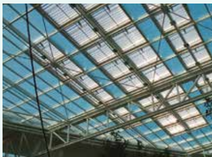
Figure 3.3 - Les verrières permettent de réaliser des volumes tampons profitables en termes thermiques.
