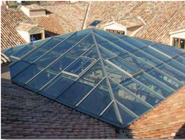
Hotel Peñafiel (Valladolid - Espanha)
