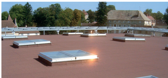
La Commanderie - Dole © Architecte X
